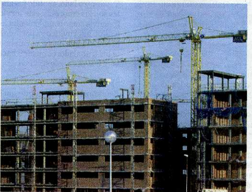
Edificios de viviendas en construcción./ARCHIVO
