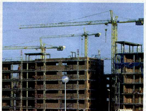
Edificios de viviendas en construcción./ARCHIVO
